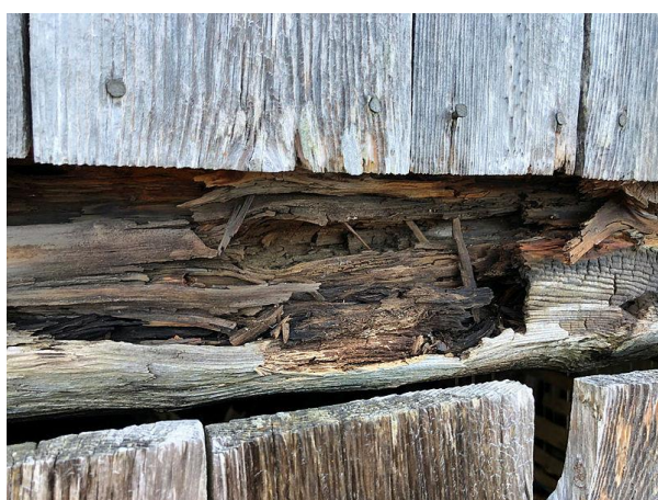
Råteskader i beten over porten
