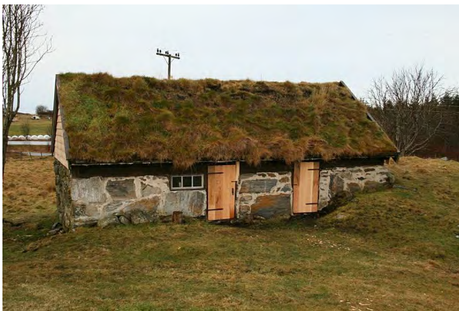
Det ble også fjernet en del masse ved dørene.
