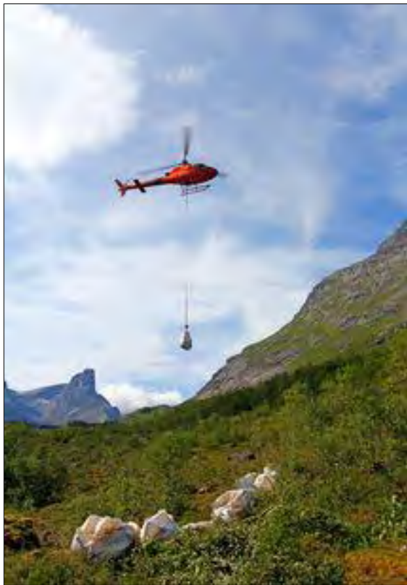
Transport av naturstein med helikopter i Vengedalen
